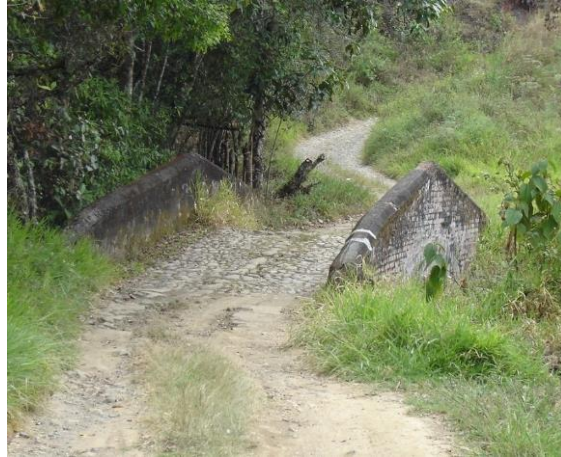
FIGURA 36. PUENTE SOBRE QUEBRADA LA VICTORIA
