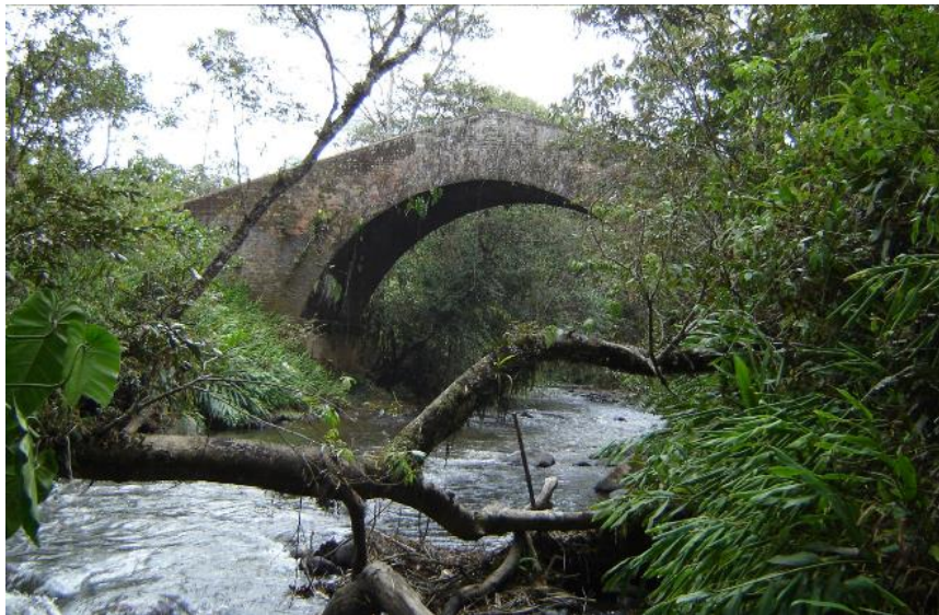
FIGURA 34. PUENTE VIEJO SOBRE EL RIO COFRE
